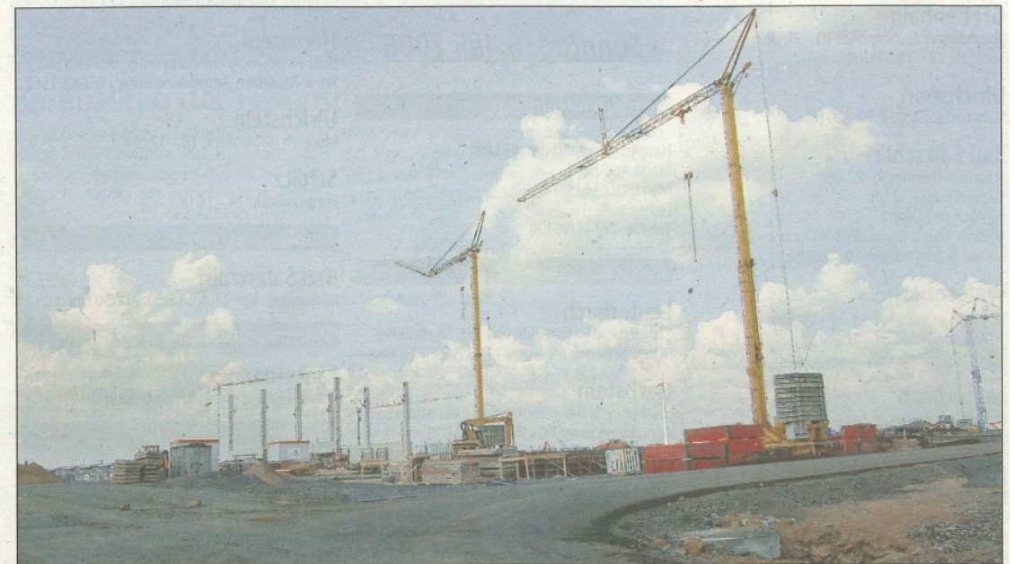
An vielen Stellen auf dem 22 Hektar großen Gelände der ersten Ausbaustufe wird derzeit unter Hochdruck gearbeitet.
