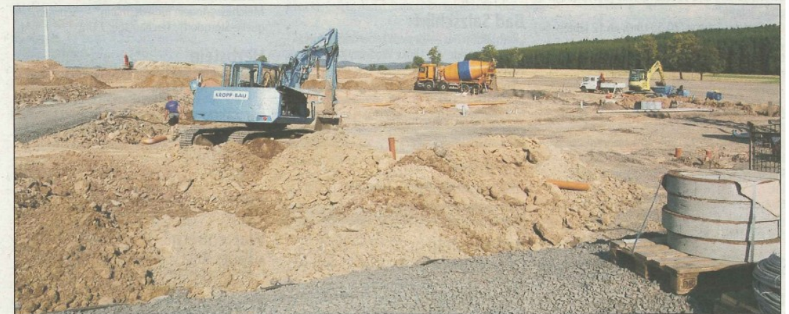
Hier wird später einmal das Kraftwerk Energie erzeugen.
