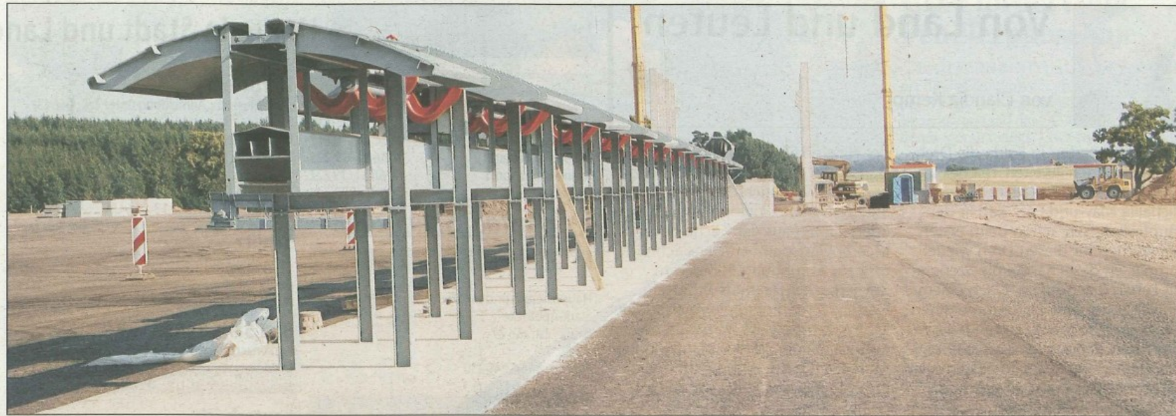
Die ersten Anlagen wie das Transportband für das neue Sägewerk Heggenstaller sind in dieser Woche installiert worden.
